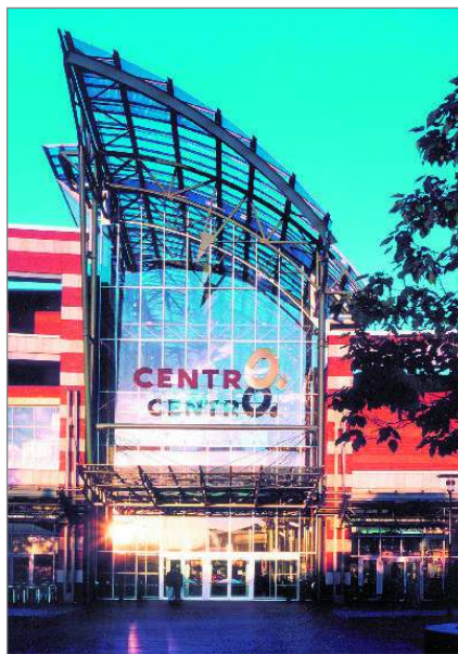
Das CentrO in Oberhausen hat nicht nur Auswirkungen auf die Innenstädte...
