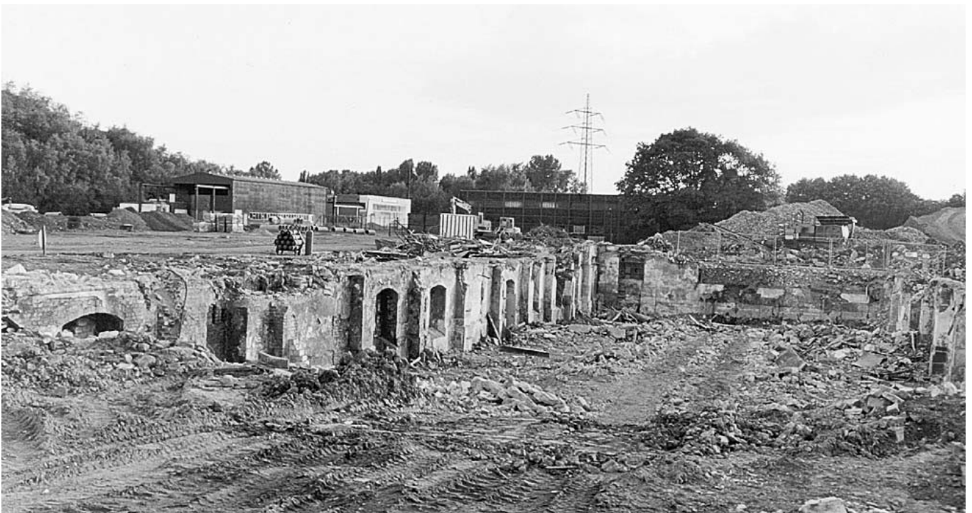
Vor dem Neubau steht meist der Abbruch nicht benötigter Gebäude.
